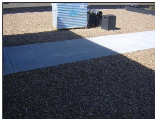
Fig. 3: Ejemplo de pasillo de mantenimiento
