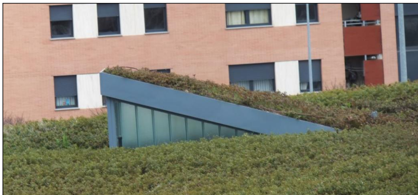
Fig. 6: Vista de la cubierta ajardinada de un edificio. Se aprecia que emerge una zona acristalada a través de la misma.
