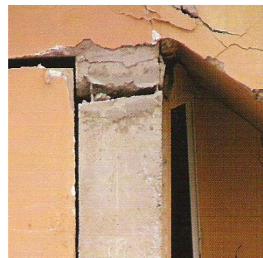
Fig. 12. Grieta por tracción
