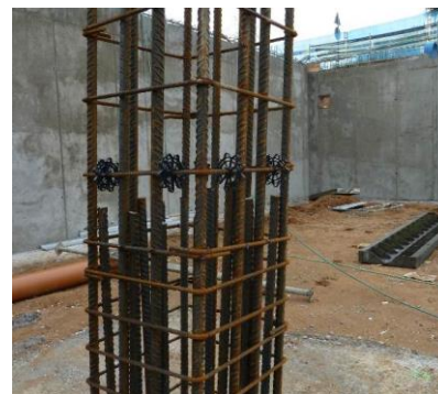
Fig. 21. Colocación separadores en el armado de soportes
