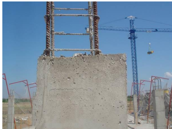
Fig. 4. Recubrimientos incorrectos
