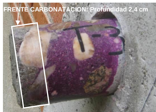
Fig. 7. Carbonatación del hormigón. Test a la fenolftaleína
