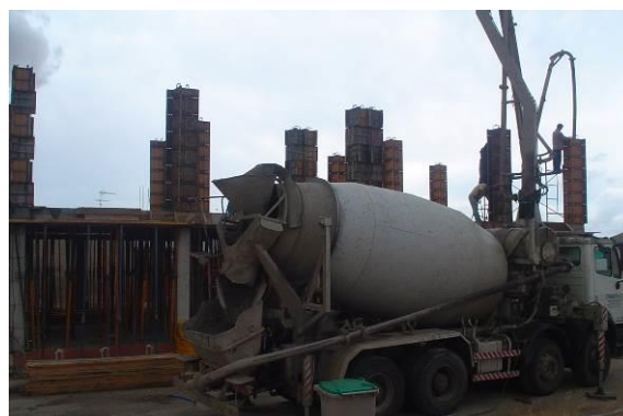
Fig. 2: Hormigonado de pilares
