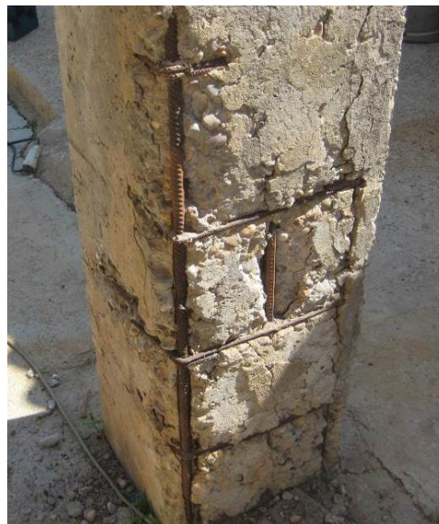
Fig. 8 y 9. Desprendimiento del hormigón por corrosión de armaduras en soportes
