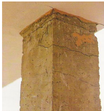
Fig. 11. Fisuras por flexión
