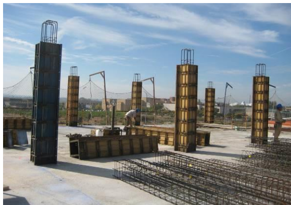
Fig. 1: Ejecución pilares hormigón armado
