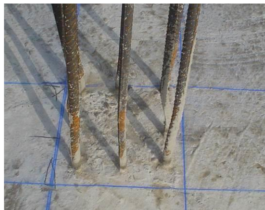
Fig. 19. Replanteo pilar para montaje encofrado
