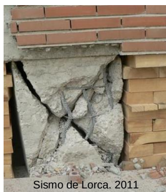
Fig.10. Fisuras por compresión en pilar corto
