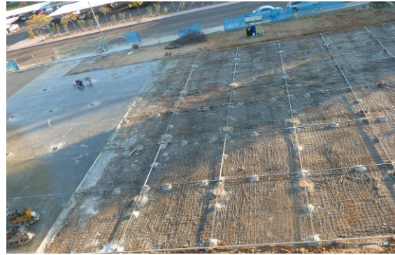
Fig. 1: Ejecución solera de hormigón
