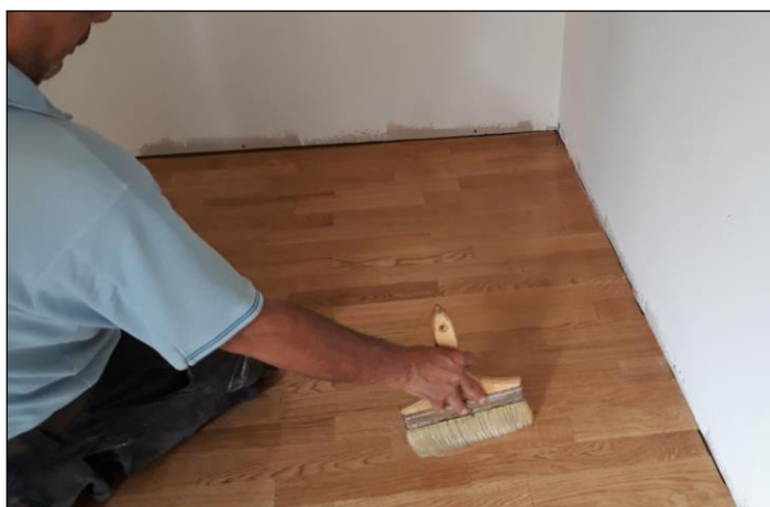
Fig. 9: Aplicación a mano de una capa de barniz mediante la utilización de una brocha ancha
