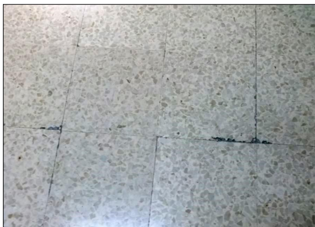
Fig. 4: Disposición de un solado perdido de terrazo a partir de baldosas reutilizadas de una vivienda antigua
