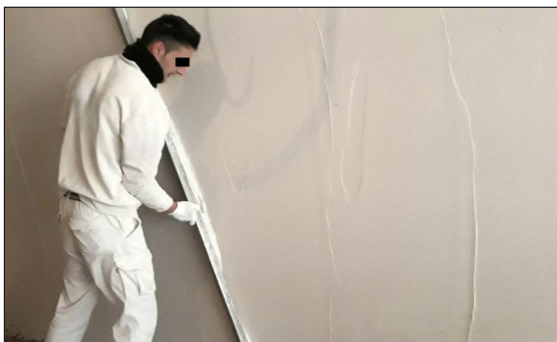
Fig. 4: Alisado mediante regla de un guarnecido de yeso durante la realización de un paño
