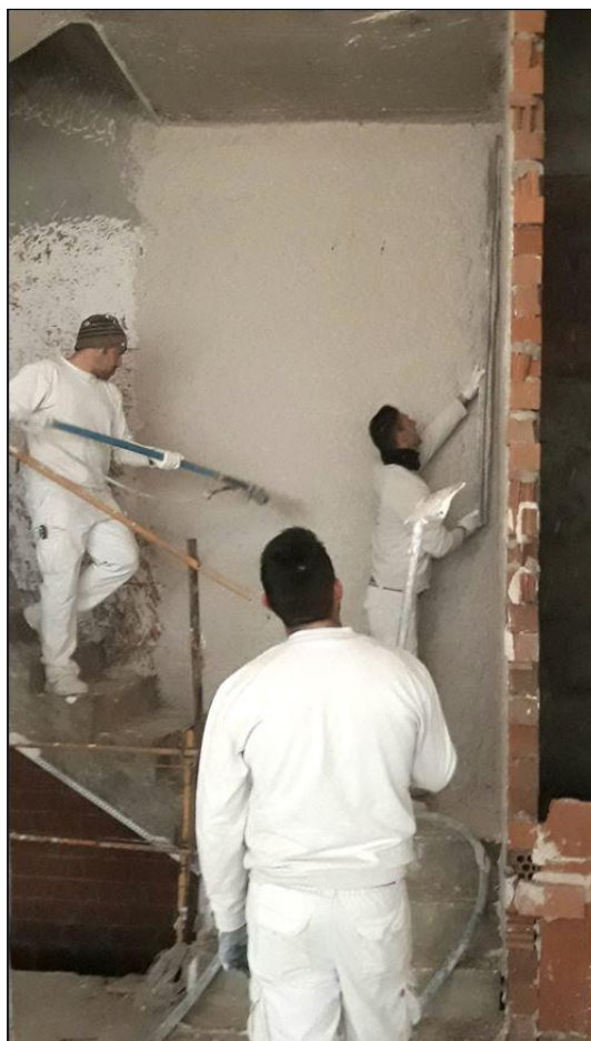
Fig. 6: Vista de los trabajos de enyesado de una caja de escalera en un bloque de pisos
