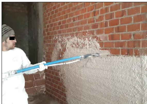
Fig. 1: Aplicación del yeso mediante proyección mecánica
