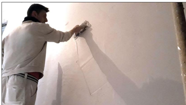
Fig. 7: Proceso de conformación de la capa de acabado de un revestimiento de yeso
