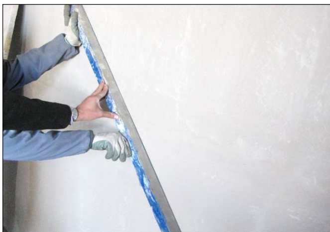
Fig. 8: Comprobación de la planeidad de un guarnecido recién ejecutado
