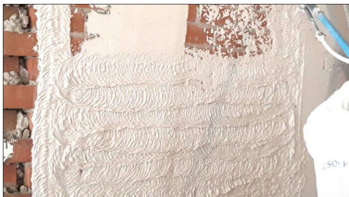
Fig. 5: Primer plano de las franjas de yeso con trazado de zig-zag, formadas por la aplicación de éste mediante proyección mecánica
