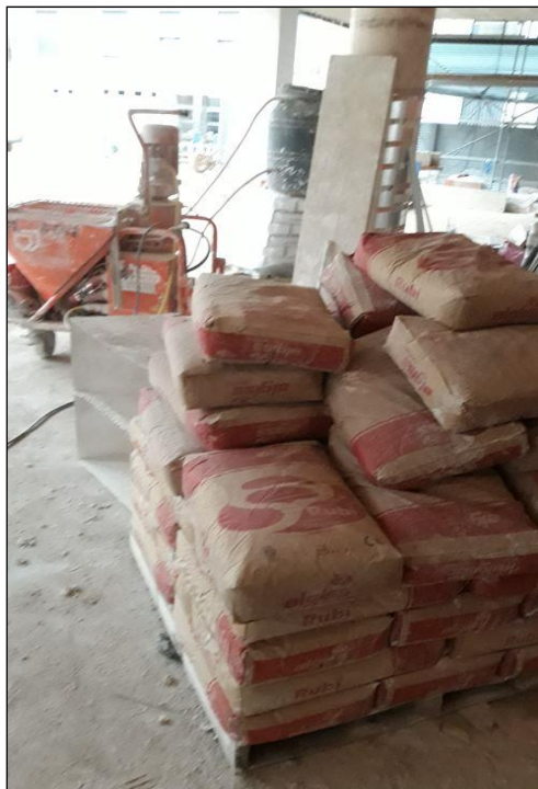
Fig. 8: Acopio de sacos de yeso en una planta, preparados para ser vertidos en una amasadora
