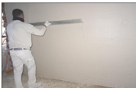
Fig. 2: Realización de un guarnecido sobre un paramento vertical
