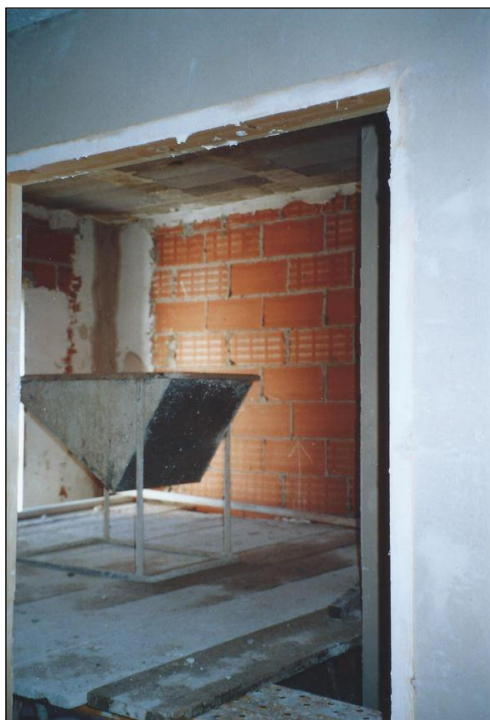
Fig. 6: Colocación de una cubeta yesera (pastera) sobre tabloncillos para proceder al guarnecido de una habitación
