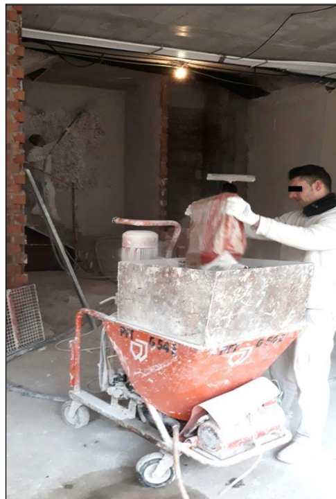
Fig. 7: Proceso de vertido de un saco de yeso en polvo en una amasadora eléctrica para obtener la pasta
