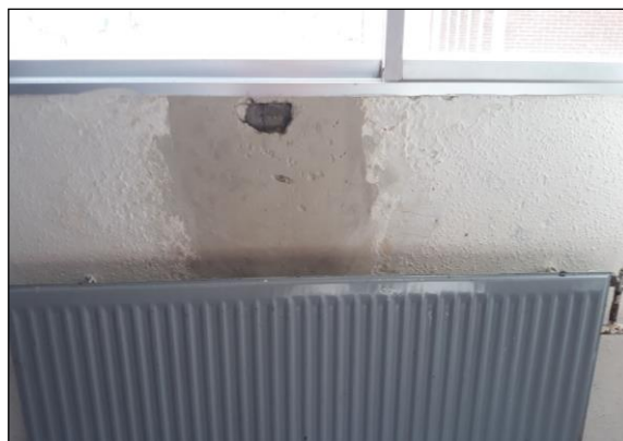
Fig. 1: Reparación de humedad en un revestimiento de yeso
