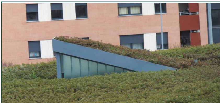
Fig. 6: Vista de la cubierta ajardinada de un edificio. Se aprecia que emerge una zona acristalada a través de la misma.
