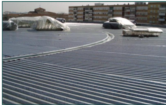
Fig. 2: Vista del soporte estructural de una cubierta deck
