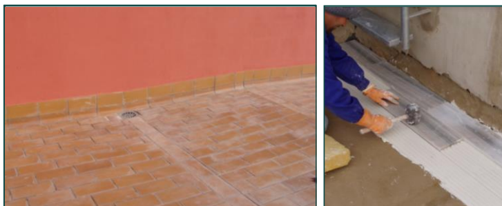
Fig. 4-5: Colocación de baldosas cerámicas y de mármol en una azotea
