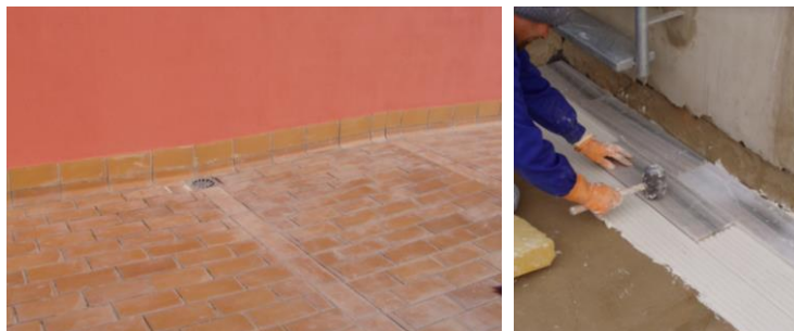
Fig. 4-5: Colocación de baldosas cerámicas y de mármol en una azotea
