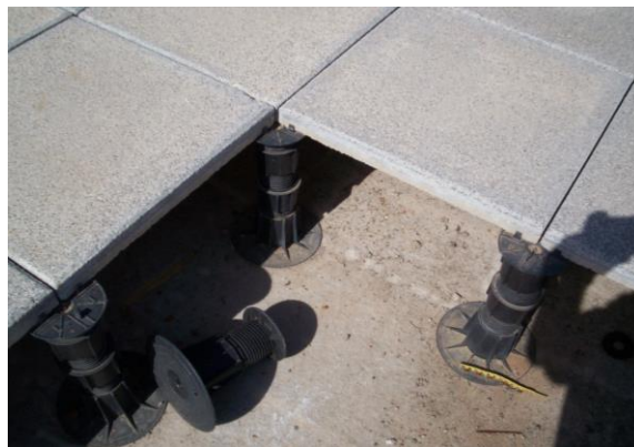
Fig. 1: Colocación de "plots" en cubierta de solado flotante
