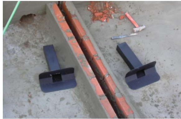
Fig. 1: Junta de dilatación resuelta en forma resaltada, con los desagües de cada paño preparados para situar
