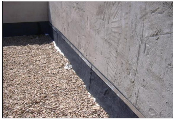
Fig. 1: Zona lateral de cubierta no transitable bituminosa
