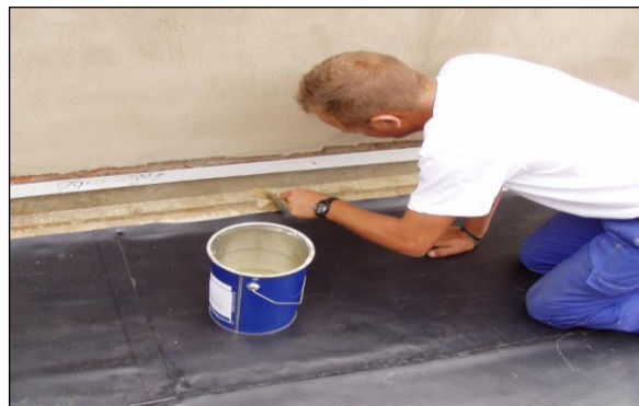
Fig. 2: Ejecución de encuentro, en cubierta con lámina de PVC-P
