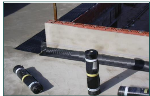
Fig. 4: Colocación de la 'banda de adherencia' en un encuentro con pretil (erróneamente no se ha aplicado antes una imprimación bituminosa líquida).
