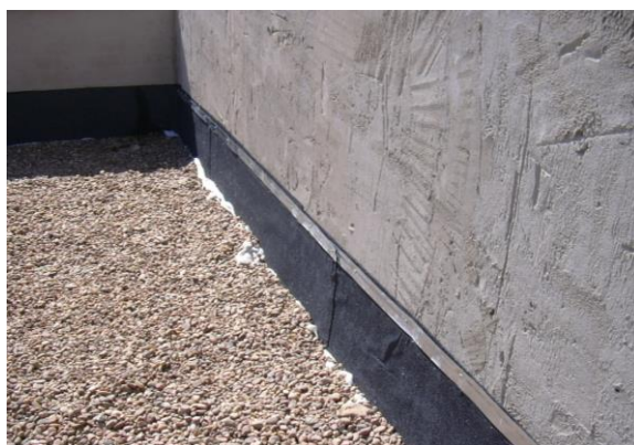
Fig. 1: Zona lateral de cubierta no transitable bituminosa
