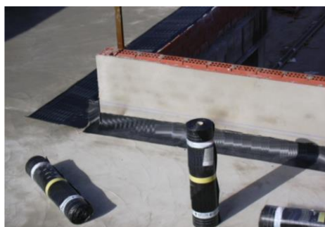
Fig. 4: Colocación de la 'banda de adherencia' en un encuentro con pretil (erróneamente no se ha aplicado antes una imprimación bituminosa líquida).
