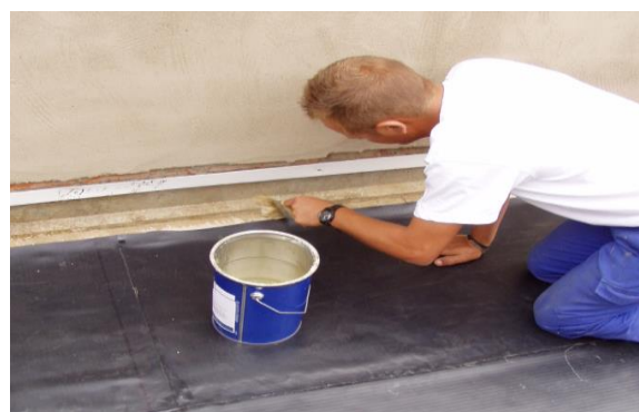
Fig. 2: Ejecución de encuentro, en cubierta con lámina de PVC
