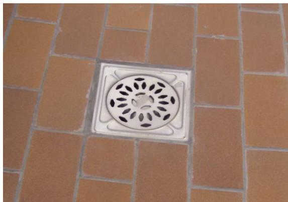
Fig. 1: Cazoleta en cubierta plana transitable
