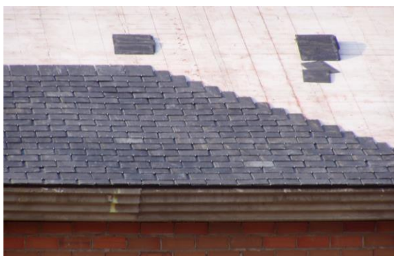
Fig. 2: Proceso de ejecución de un faldón con piezas de pizarra
