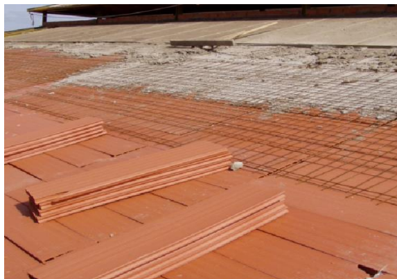
Fig. 1: Extendido de capa de mortero sobre tablero cerámico
