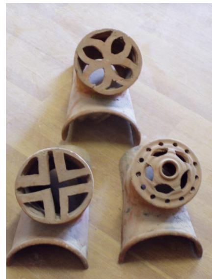
Fig. 4: Ejemplos de piezas especiales de ventilación antiguas para cubiertas inclinadas de teja cerámica curva.
