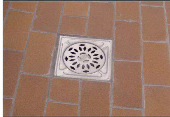
Fig. 1: Cazoleta en cubierta plana transitable
