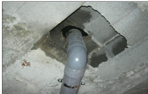
Fig. 2: Humedad debido a la pérdida de una cazoleta
