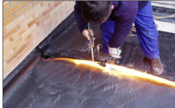
Fig. 2: Proceso de colocación de una lámina imperm. bituminosa
