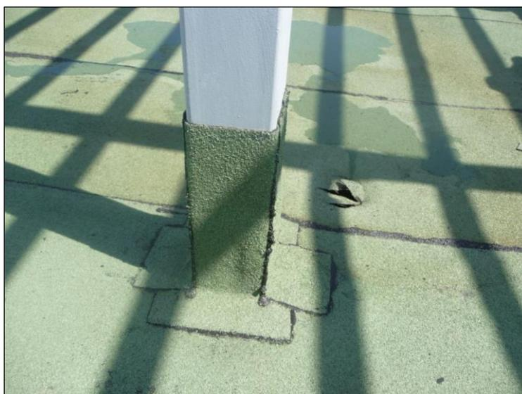
Fig. 6: Cubierta plana no transitable impermeabilizada con lámina bituminosa autoprotégida en su encuentro con un elemento pasante (fuste metálico de una pérgola).
