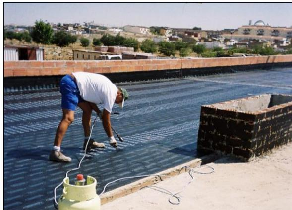
Fig. 4: Operario efectuando las uniones de una lámina impermeabilizante bituminosa
