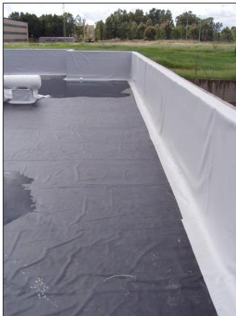
Fig. 5: Impermeabilización realizada con una lámina de PVC-P. En la solución adoptada se decidió cubrir toda la parte interior del pretil con la lámina de peto.
