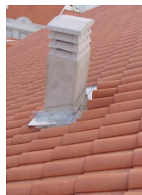
Fig. 7: Encuentro de un faldón con un "shunt"
