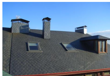
Fig. 6: Tejado de pizarra con la existencia de distintos puntos singulares: canalones, ventanas, chimeneas, juntas de dilatación...
