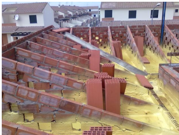
Fig. 8: Ejecución de una cubierta en donde se aprecia la formación de pendientes, aplicación del aislante térmico sobre el forjado, así como realización de una limahoya y del canalón.
