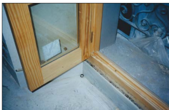
Fig. 2: Colocación de vidrio en carpintería de madera
