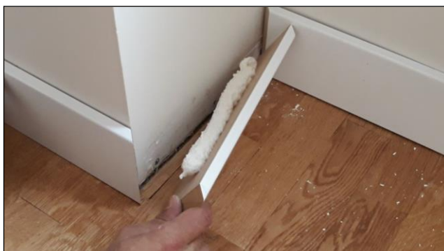
Fig. 9: Acabado del encuentro perimetral de un pavimento. Colocación de los rodapiés fijados con espuma y saetines.
