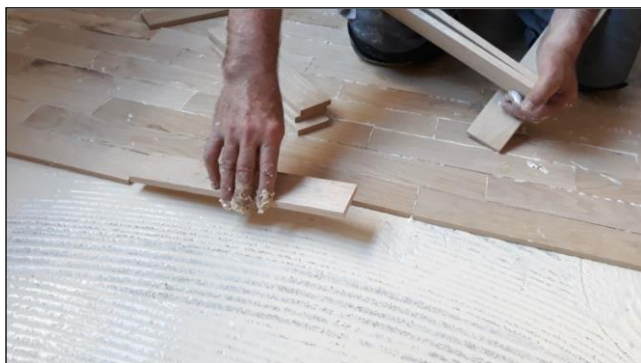
Fig. 6: Parqué colocado sobre solera de hormigón. Aplicación del adhesivo inferior y disposición de las tablillas.
