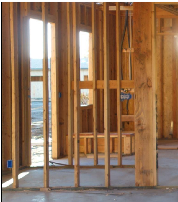
Fig. 6: Proceso de montaje de los montantes (pies derechos) y los testeros (soleras)
