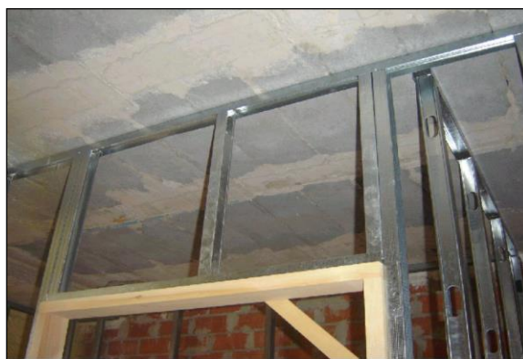
Fig. 1: Montaje de subestructura en tabique de placas de cemento
