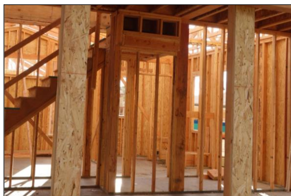
Fig. 2: Ejecución del entramado en una partición de madera
