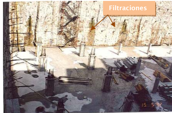
Fig. 1: Ejecución pantalla continua de H.A.
