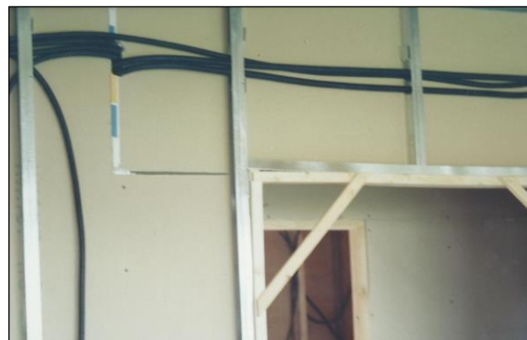
Fig. 2: Colocación de una 'pieza de dintel pasante' en un tabique
