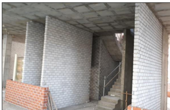
Fig. 2: Particiones interiores realizadas con ladrillo silicocalcáreo
