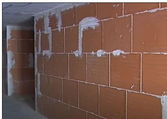
Fig. 1: Tabique cerámico efectuado con ladrillo gran formato
