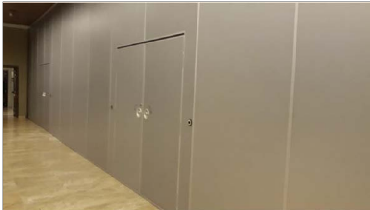
Fig. 8: Vista de una 'mampara móvil suspendida' con todas las secciones modulares del tipo opaco y con algunas de ellas con la función de puertas.
