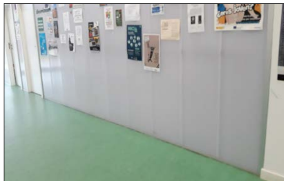
Fig. 2: Tabiques realizados con paneles de policarbonato
