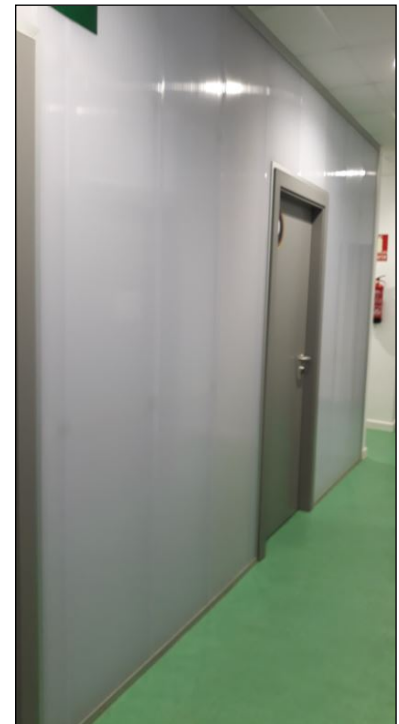
Fig. 4 y Fig. 5: Ejemplos de utilización del policarbonato como partición. A la izquierda como cierre de un baño usando piezas de color, y a la derecha en blanco para configurar el paramento divisorio entre un pasillo y varios despachos.
