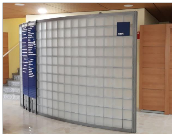
Fig. 8: Separación realizada con piezas de vidrio moldeado con enmarcado en perfiles de acero en U para hacer de separación ambiental
