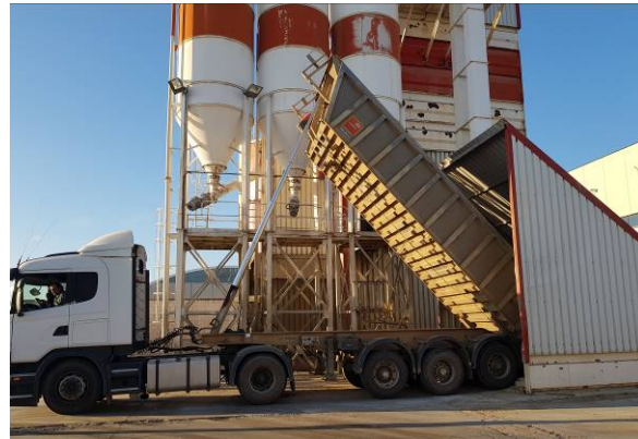
Fig. 1: Suministro de arena en planta de hormigones
