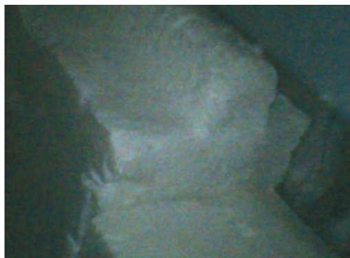
Figuras 25 y 26. A la izquierda cata realizada en el antepecho de una cubierta y a la derecha inspección de aislamiento en una cámara de aire mediante un boroscopio.
