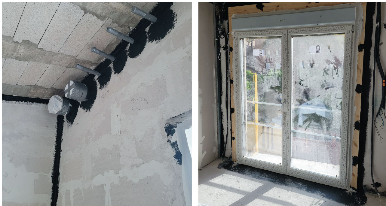
Figura 67. Tratamiento de puntos con posibles filtraciones con cintas y pinturas herméticas.
