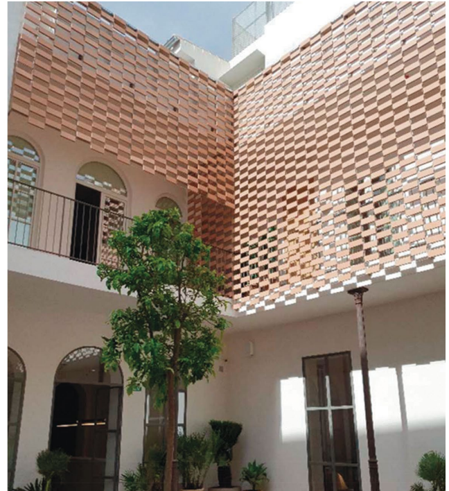
Figura 65. Piel cerámica como protección solar. Sistema Flexbrick
