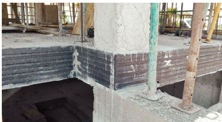
Figura 36. Utilización de TR-Canto forjado colocado en fase de estructura. Fuente: Grupo Valero.
