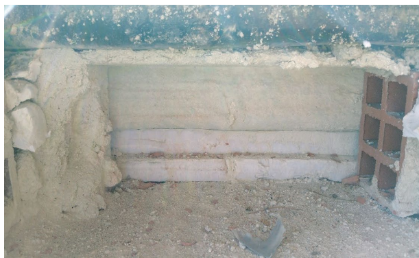
Figuras 25 y 26. A la izquierda cata realizada en el antepecho de una cubierta y a la derecha inspección de aislamiento en una cámara de aire mediante un boroscopio.
