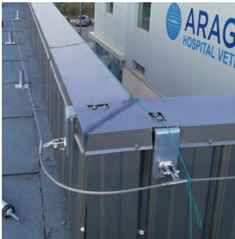
*Imagen 64. Dispositivo de anclaje tipo C instalado en cubierta para mantenimiento.*
