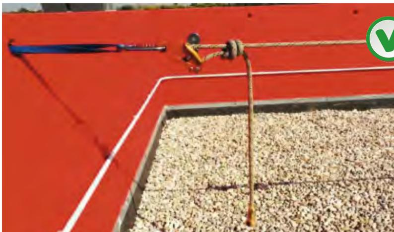
*Imagen 70. Combinación de dispositivo tipo B (azul), conector EN 362 y dispositivo EN 795 tipo B y C (Grillón de PETZL).*
