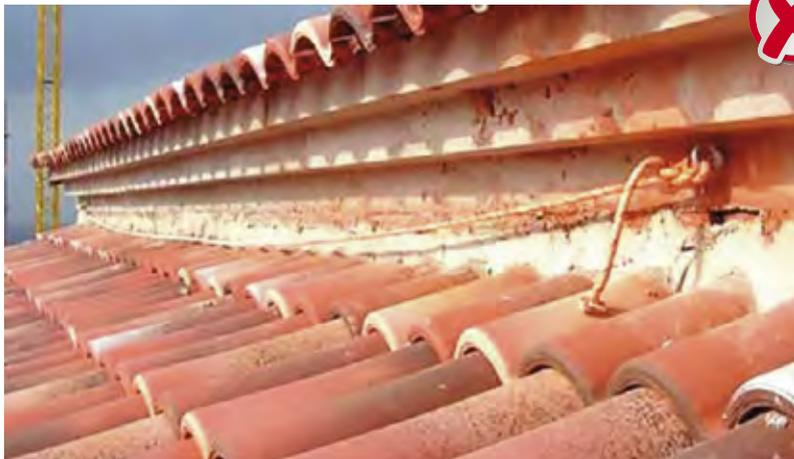
*Imagen 69. Ejemplo de línea no aceptable formada por cuerda y anclajes no conformes con la nueva EN 795, no dispone de certificación B ni C.*
