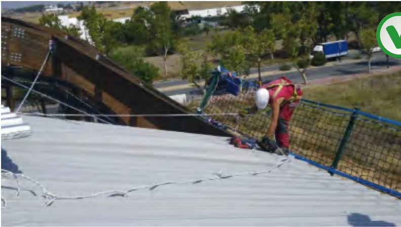
*Imagen 65. En este ejemplo podemos ver un sistema de sujeción (línea en tensión) con una protección colectiva por detrás.*
