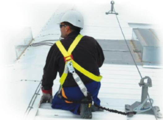
*Imagen 11. Dispositivo de anclaje tipo C.*
