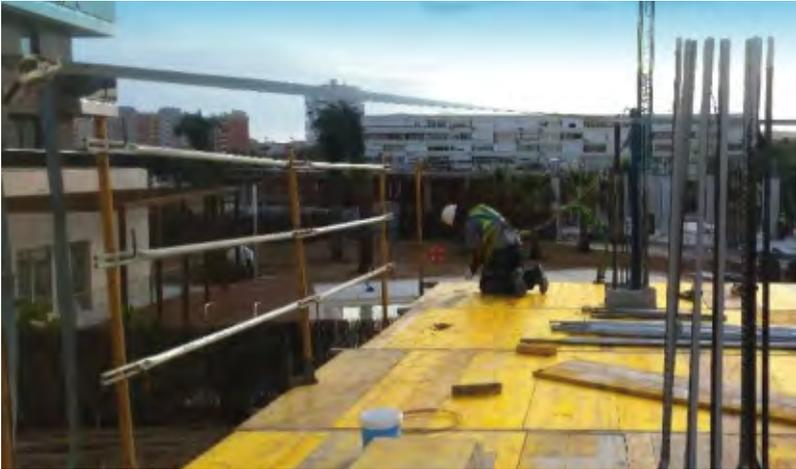
Imagen 52. Equipo de amarre sobre anclaje tipo B anclado sobre mástiles a los pilares.
