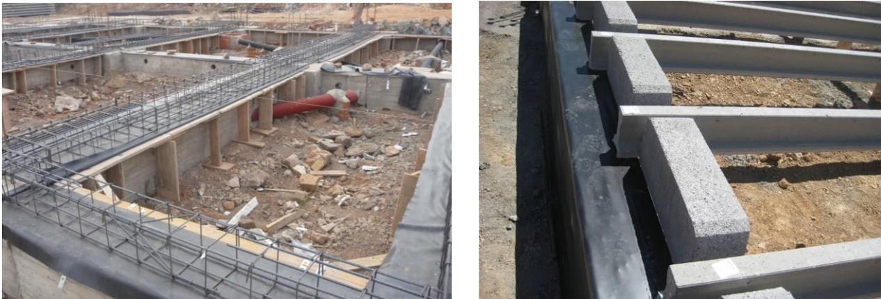
Fig.20 y 21. Barrera de corte de humedad en muros de apoyo forjado sanitario
