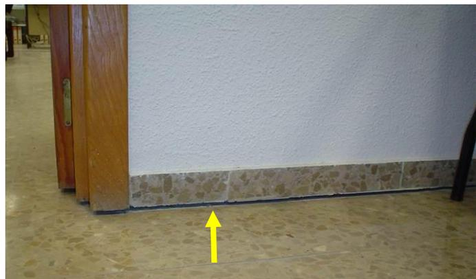
Fig. 9. Separación tabique-solado por deformación del forjado
