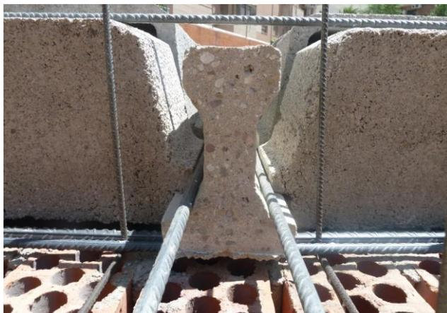
Fig. 6. Apoyo vigueta sobre armado inferior de zuncho con ausencia de recubrimientos. Incorrecto
