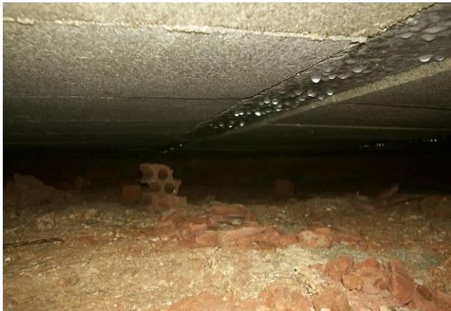
Fig. 4. Ausencia ventilación cámara sanitaria. Condensaciones
