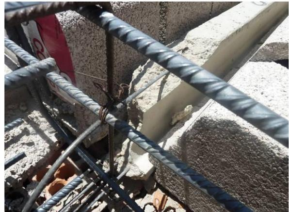
Fig. 5. Descabezado de vigueta. Incorrecto.
