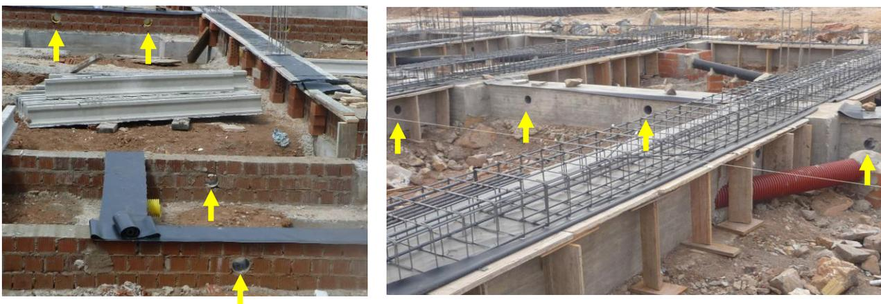
Fig.22 y 23. Apertura de ventilación en muros y/o vigas bajo forjado sanitario
