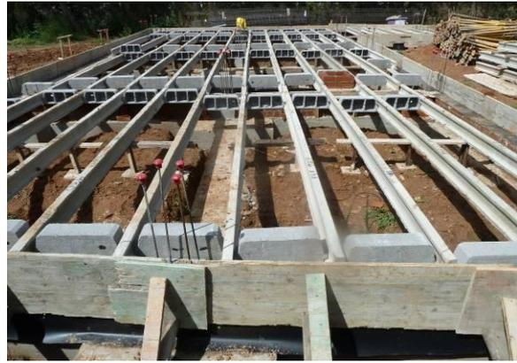
Fig. 1: Vista general montaje viguetas forjado sanitario
