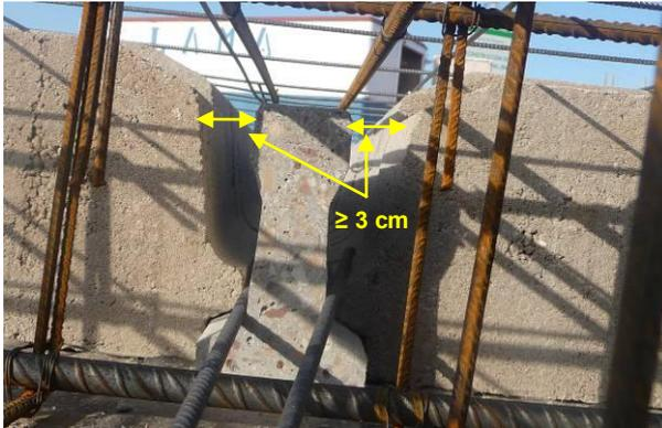
Fig. 16. Compatibilidad viga-pieza entrevigado
