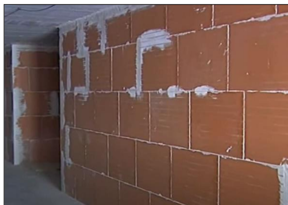
Fig. 1: Tabique cerámico efectuado con ladrillo gran formato
