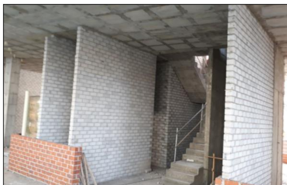
Fig. 2: Particiones interiores realizadas con ladrillo silicocalcáreo
