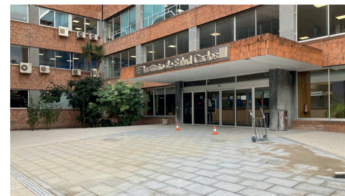
Foto 6. Entrada. Estado Final.
