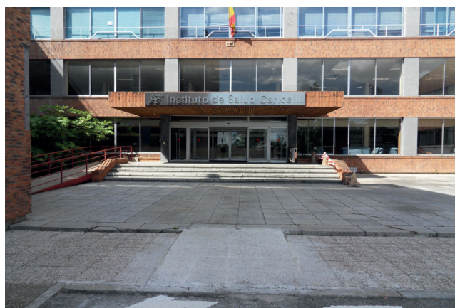
Foto 1. Estado Inicial Acceso Principal. Rampa y Escaleras. Fuente: ISC III
