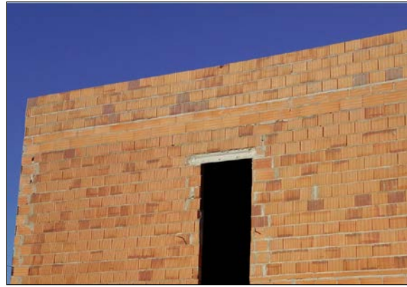
Fig. 1: Fachada de bloque cerámico que irá revestida de mortero
