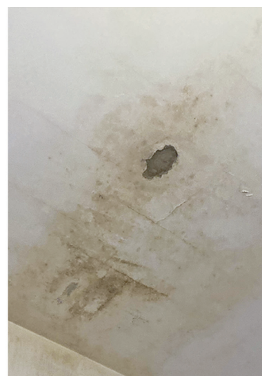
Imagen 17. Filtración.
