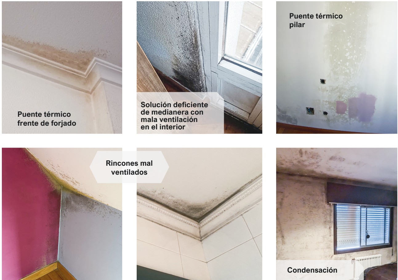
Imagen 19. Ejemplos de formación de moho superficial. (Fotografías cortesía de Carlos Mato y Manuel Rañó).
