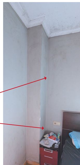
Imagen 86. Humedades en medianera: Deficiencia.
