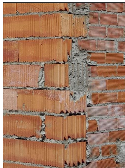
Fig. 7: Esquina de fachada donde converge el sistema Termoarcilla® y el tradicional de ladrillo. Se aprecian cortes inadecuados de piezas, macizados con cemento y enjarjes insuficientes.
