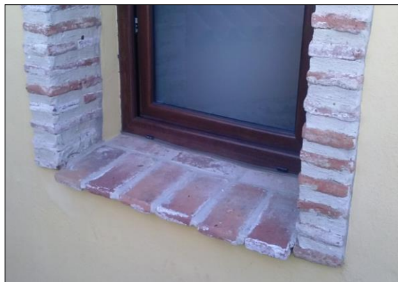
Fig. 1: Vierendeague discontinuo realizado con ladrillo manual
