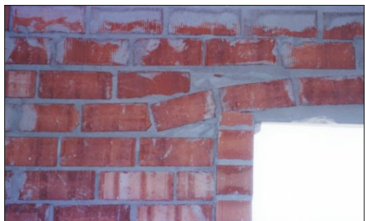
Fig. 5: Solución de dintel con arco de descarga
