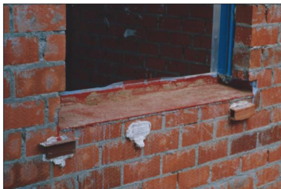
Fig. 4: Impermeabilización inferior de un vierteaguas
