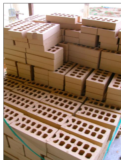
Fig. 8: Acopio en planta de ladrillos cara vista antes de ser colocados
