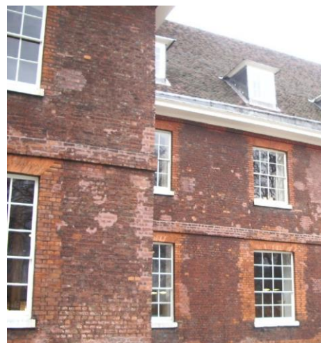
Fig. 3: Fachada de un edificio de Londres
