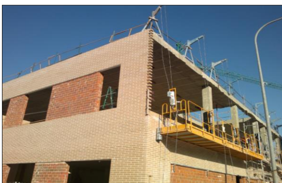
Fig.2: Ejecución de fachada con ladrillo tosco y cara vista
