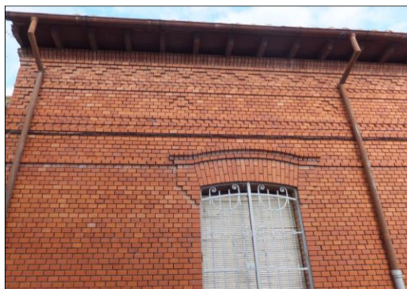
Fig.1: Fachada 1pie de L.C.V. a tizón con ornamentos geométricos
