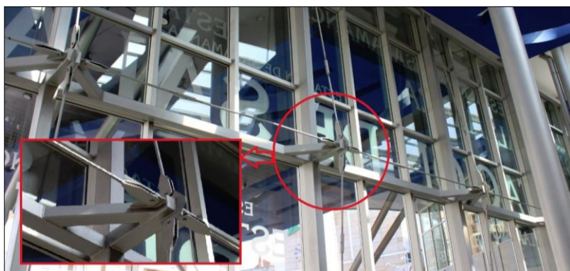
Fig.12: Fachada con vidrios insertos entre montantes y travesaños de aleación ligera, que dispone de una estructura soporte de refuerzo posterior con perfiles metálicos unidos por medio de tensores de acero.
