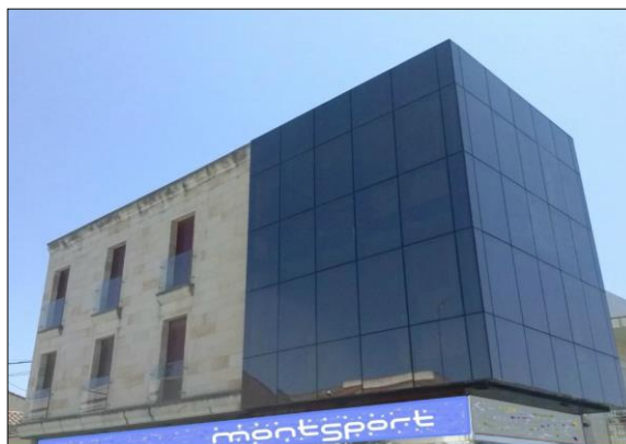
Fig.1: Fachada aplacada combinada con un muro cortina
