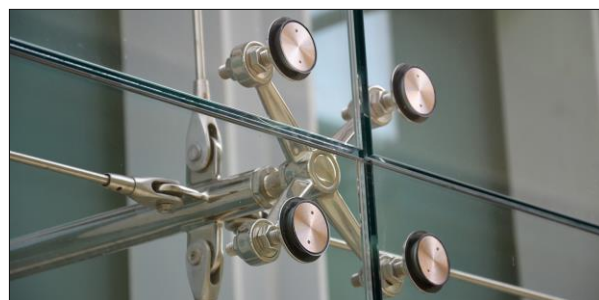
Fig.4: Piezas de fijación de fachada de vidrio abotonado
