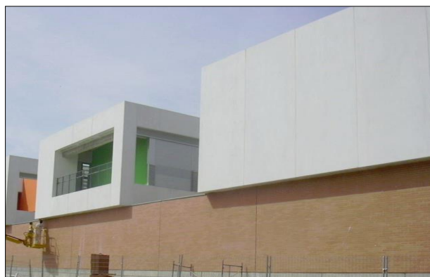
Fig.8: Fachada pesada realizada con panel prefabricado de hormigón blanco reforzado con vidrio (GRC)
