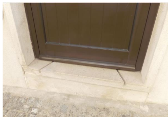
Fig. 7: Acanaladura en un umbral en una vivienda de construcción tradicional de Portugal
