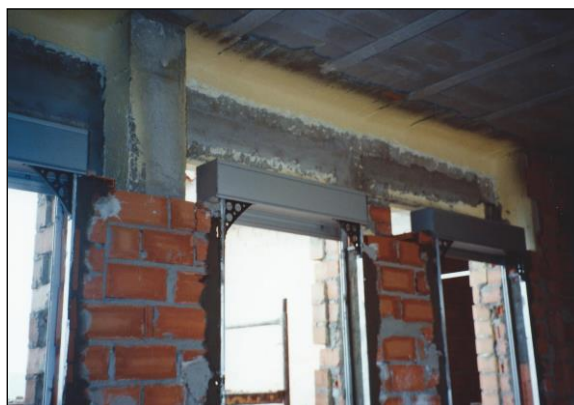
Fig. 1: Fijación de precerco con capialzado y guía incluida
