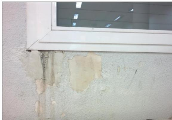
Fig. 1: Lesiones por filtración en esquina inferior de ventana
