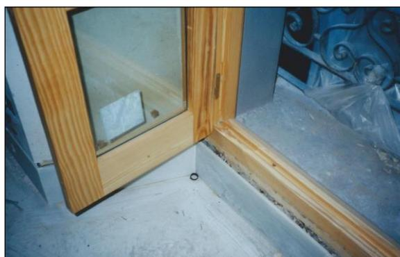
Fig. 2: Colocación de vidrio en carpintería de madera
