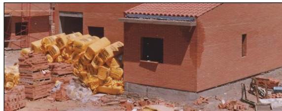
Fig. 2: Acopio de planchas de aislamiento
