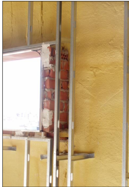
Fig. 1: Vista de la aplicación de espuma de poliuretano proyectado sobre la que se monta un trasdosado autoportante de placas de yeso laminado
