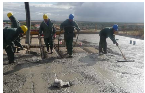
Fig. 5: Vertido y compactado del hormigón en obra
