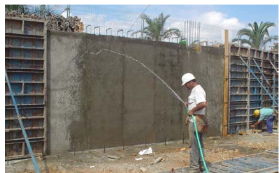
Fig. 7: Curado del hormigón en obra
