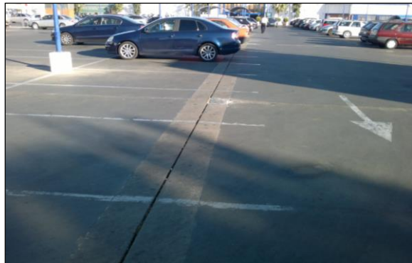
Fig. 2: Cubierta-parking para tráfico ligero
