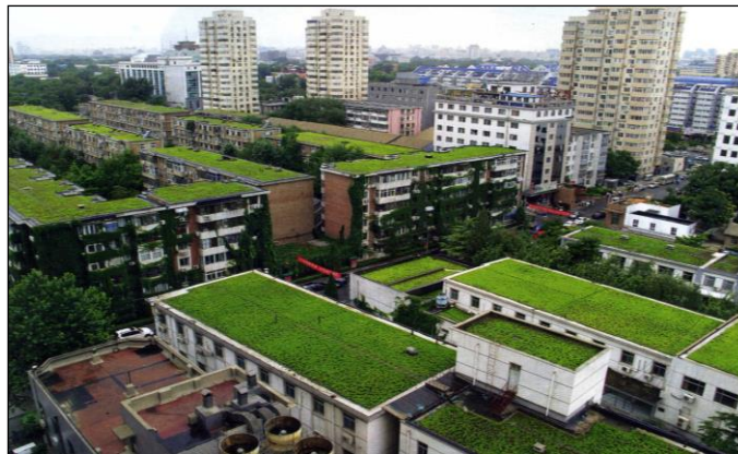
Fig. 5: Transformación en Pekín de azoteas transitables a cubiertas ajardinadas para reducir costos energéticos.
