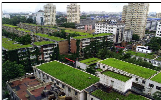
Fig. 5: Transformación en Pekín de azoteas transitables a cubiertas ajardinadas para reducir costos energéticos.
