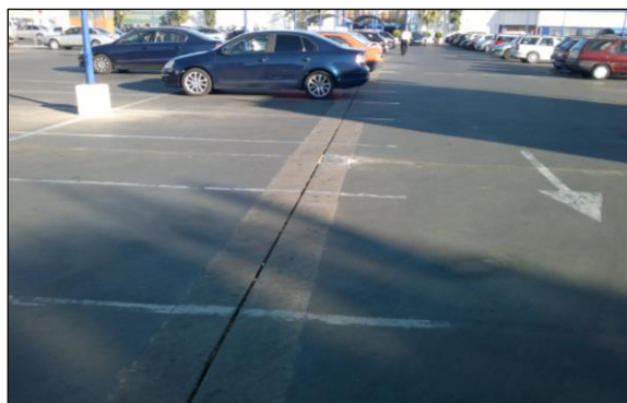
Fig. 2: Cubierta-parking para tráfico ligero
