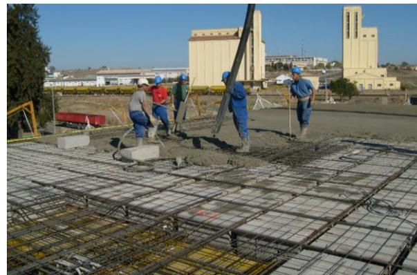
Fig. 2: Hormigonado de forjado reticular
