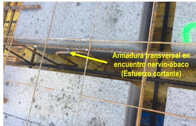
Figura 11 y 12. Armado a esfuerzos cortantes en encuentro nervio-ábaco
