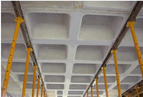
Fig. 4: Aligeramiento del forjado reticular con moldes recuperables
