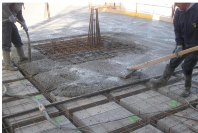
Fig. 17. Fase de hormigonado: vibrado y extendido del hormigón
