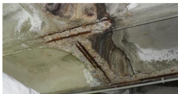
Figura 8. Fisuras por corrosión de las armaduras
