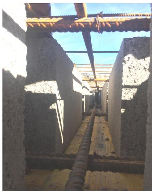
Figura 10. Armado de nervios
