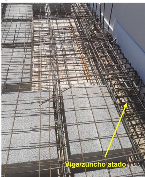
Figura 9. Armado de vigas y/o zunchos
