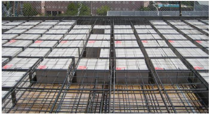
Fig. 5: Aligeramiento del forjado reticular con moldes permanentes de hormigón
