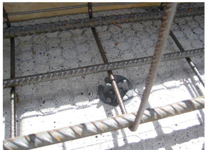
Figura 14. Recubrimientos. Colocación de separadores
