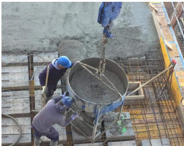
Fig. 16. Fase de hormigonado: vertido de hormigón con cubilote
