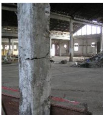
Fig. 13. Rotura a flexión por pandeo de soporte
