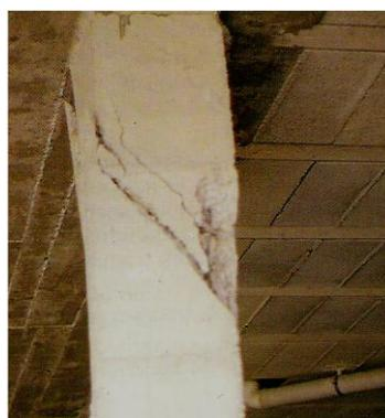
Fig. 14. Grieta por cortante en soporte
