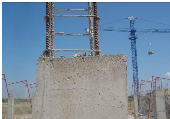
Fig. 4. Recubrimientos incorrectos. Ausencia separadores
