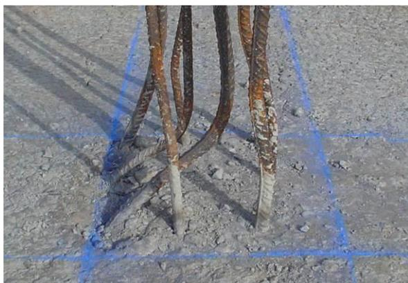
Fig. 3. Deficiente replanteo y grifado de armaduras
