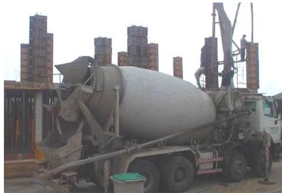
Fig. 2: Hormigonado de pilares
