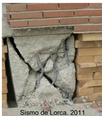
Fig.10. Fisuras por compresión en pilar corto
