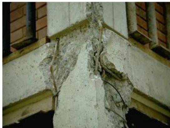
Fig. 16. Rotura con pandeo de las armaduras
