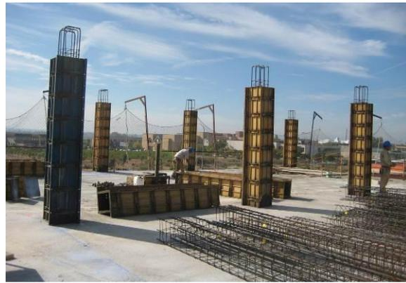
Fig. 1: Ejecución pilares hormigón armado
