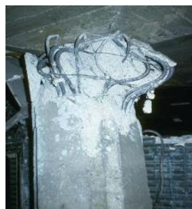
Fig. 18. Rotura por aplastamiento, pandeo de las armaduras
