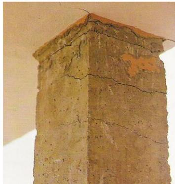
Fig. 11. Fisuras por flexión
