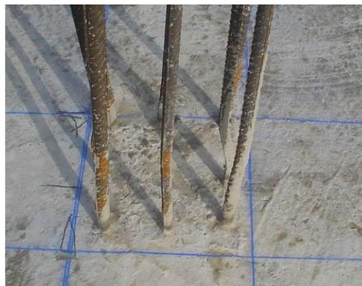
Fig. 19. Replanteo pilar para montaje encofrado
