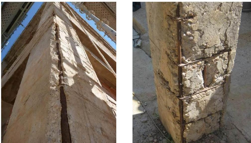
Fig. 8 y 9. Desprendimiento del hormigón por corrosión de armaduras en soportes
