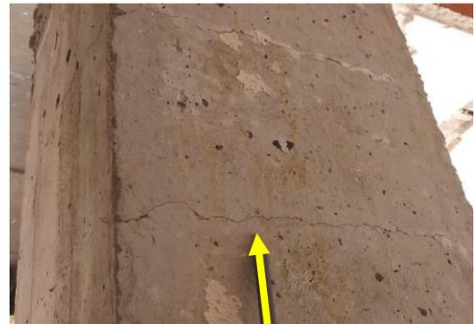
Fig. 6. Fisuración por retracción en soportes
