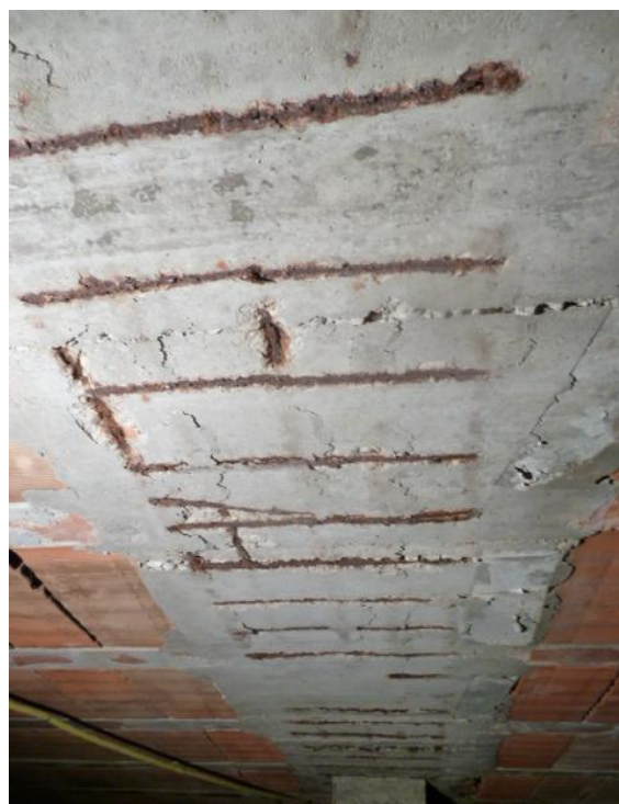
Fig. 8. Oxidación/Corrosión del armado inferior de viga de forjado. Deficiente recubrimiento del armado.
