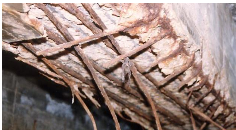
Fig. 10. Corrosión en el armado de viga por ataque de cloruros. Zona marítima
