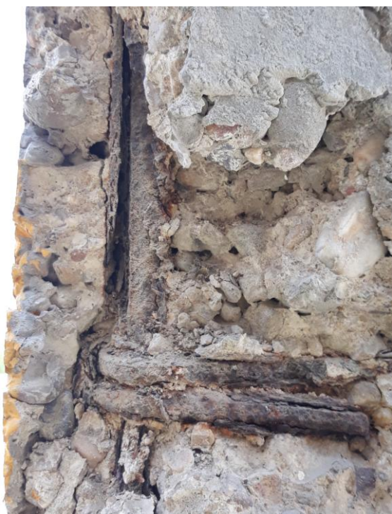
Fig. 7. Corrosión de las armaduras y desprendimiento del hormigón de un pilar.
