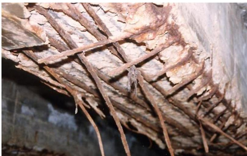
Fig. 10. Corrosión en el armado de viga por ataque de cloruros. Zona marítima
