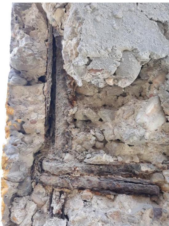
Fig. 7. Corrosión de las armaduras y desprendimiento del hormigón de un pilar.
