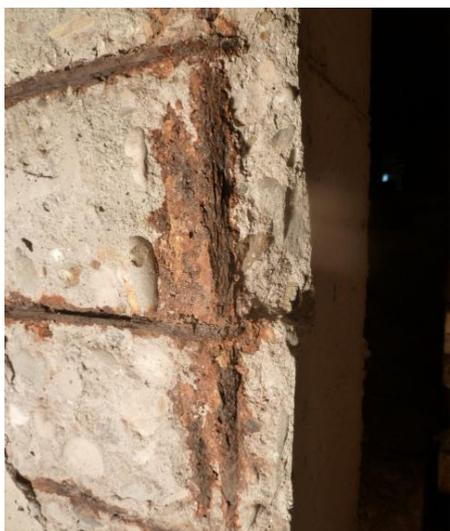
Fig. 10. Corrosión de las barras corrugadas de un pilar. Condiciones ambientales. Carbonatación
