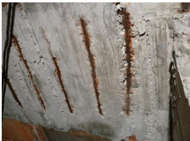
Fig. 6. Deficiente recubrimiento. Corrosión de la armadura
