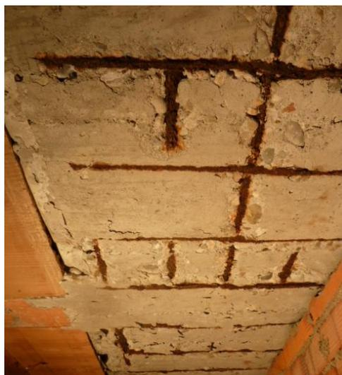
Fig. 11. Corrosión del armado de una viga. Ausencia recubrimiento
