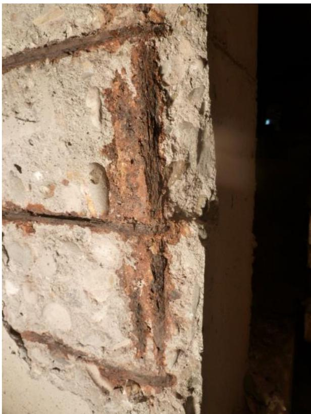
Fig. 5: Corrosión de las barras corrugadas de un pilar. Condiciones ambientales. Carbonatación
