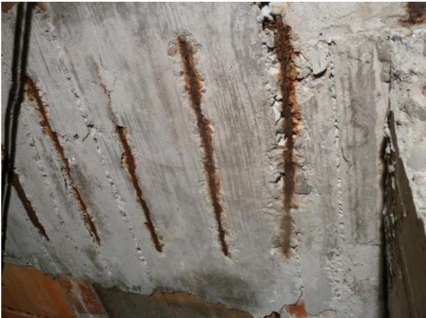
Fig. 3 Deficiente recubrimiento. Corrosión de la armadura
