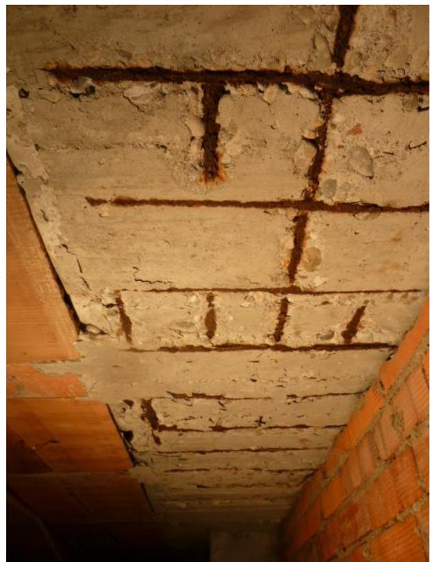
Fig. 6: Corrosión del armado de una viga pilar. Ausencia recubrimiento
