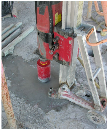
Fig. 8: Extracción probetas testigos
